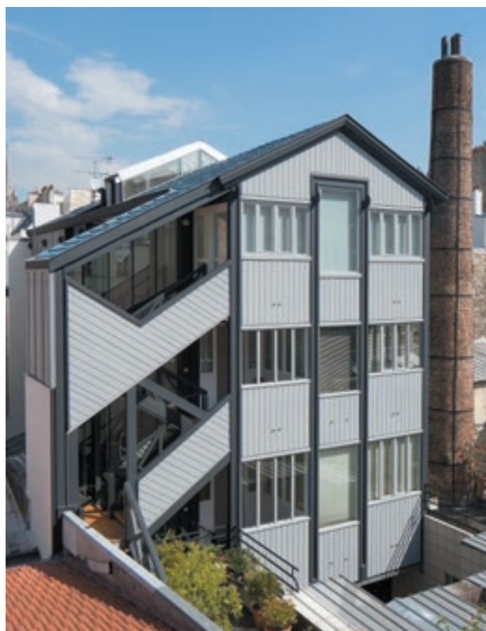
Logements, Paris (France) - Architecte : Follacci - Entreprise : Universelle de couverture
