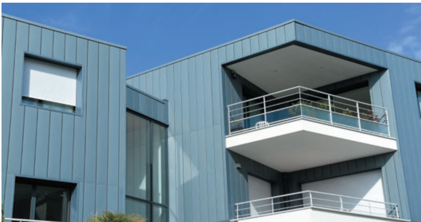
Résidence «Le Grand Large», Larmor Plage (France) - Architecte : Michel Quemener - Entreprise : SARL LEPENHER
