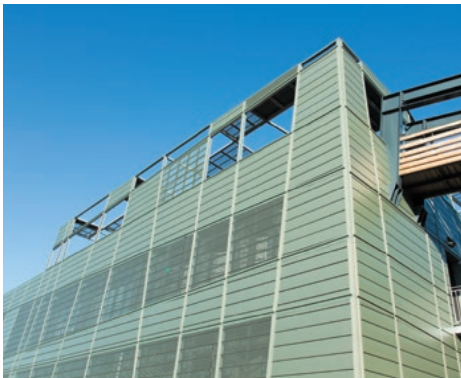
IUT, Aurillac (France) - Architecte : Trinh et Laudat - Entreprise : Sacan
