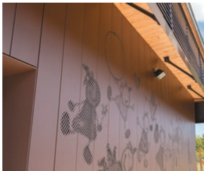
Maison des enfants Françoise Dolto, Sainte Savine (France) - Architecte : Anne Toutut - Entreprise : Les Trois A
